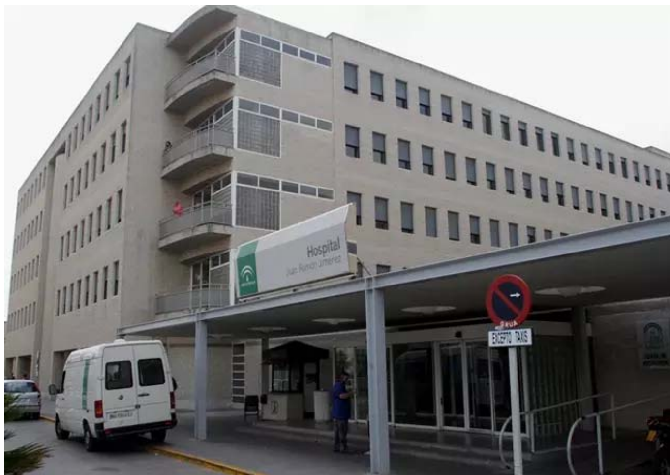
Archivo - Vista exterior del Hospital Juan Ramón Jiménez de Huelva - EUROPA PRESS - Archivo
