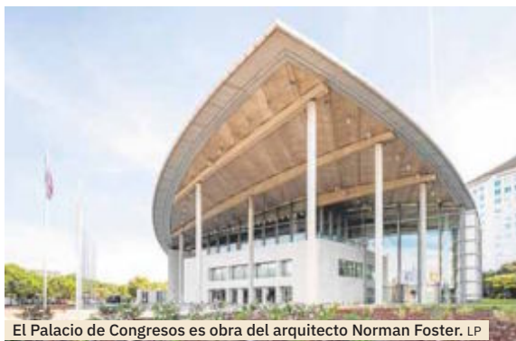
El Palacio de Congresos es obra del arquitecto Norman Foster. LP
